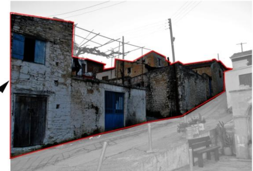
Ανομοιομορφία στα επίπεδα οροφής των κατοικιών
